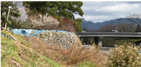
石手湯渡町の湯渡橋に残る鎌出し
