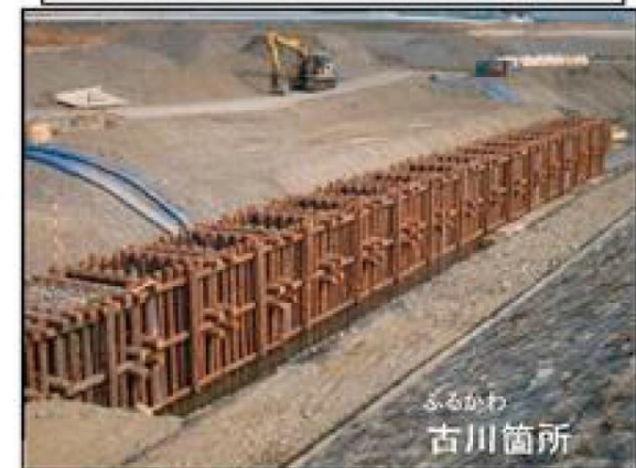
護岸根継(木工枠)施工状況写真
