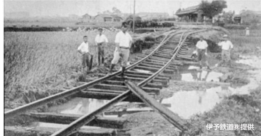
伊予鉄道の被災状況
