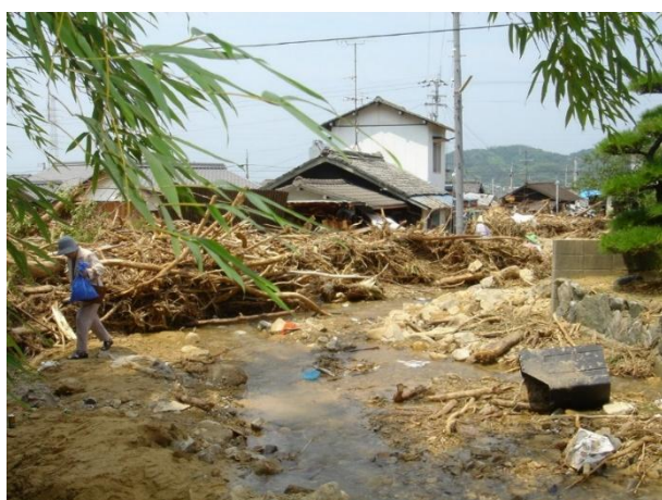
平成 16 年の台風豪雨による新居浜市（愛媛県）での土石流災害 和泉層群の風化した斜面が崩壊して土石流化し、谷の出口に建つ家屋を襲った
