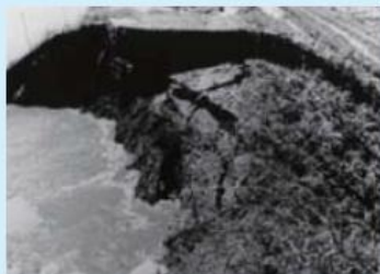
川表法面陥没し堤防全体の陥没が始まる
